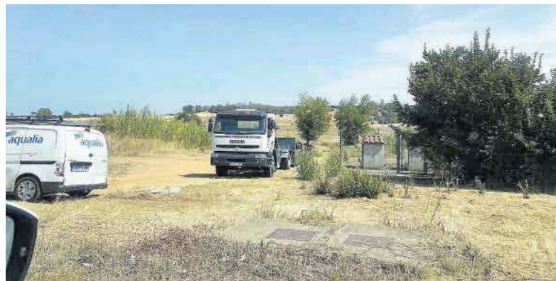
Trabajadores de Aqualia, reparando la avería en el anillo, a la altura de Sancha Brava, el 31 de agosto.
